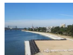
治水対策の推進(河川改修)
